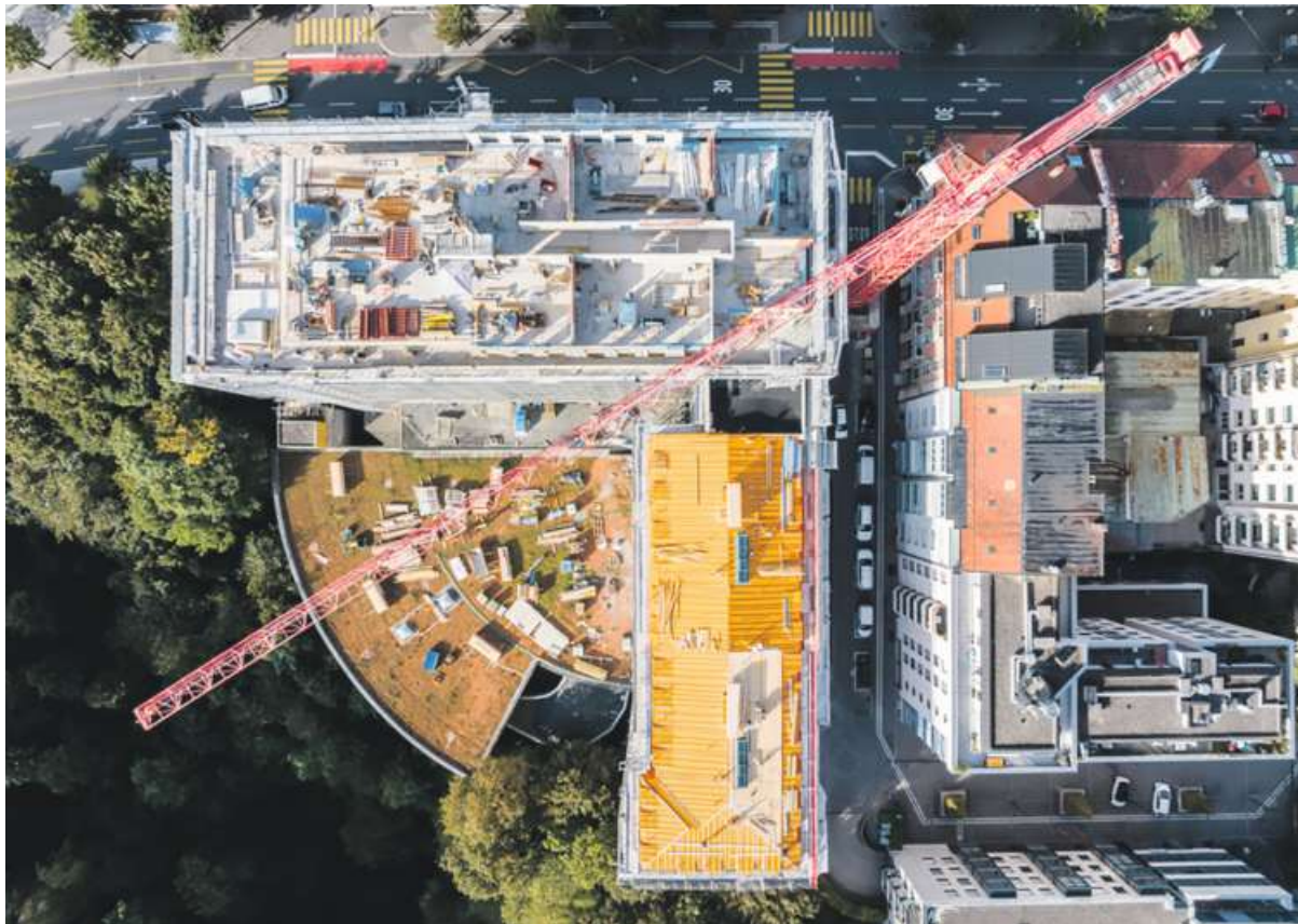
Totalsanierung des Gebäudekomplexes an der Ecke Boulevard des Pérolles und Rue Jacques-Vogt in Fribourg. INDUNI
